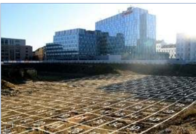
bild: jp immobilien Auf 200 Parzellen wird gegraben.
