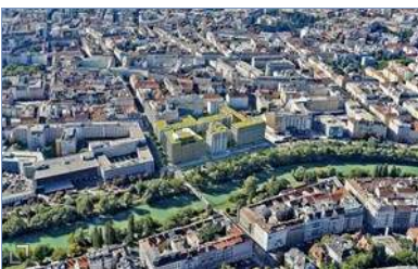
visualisierung: ca immo Fünf Baukörper werden in den nächsten Jahren dort entstehen, wo jetzt noch gebuddelt wird.
